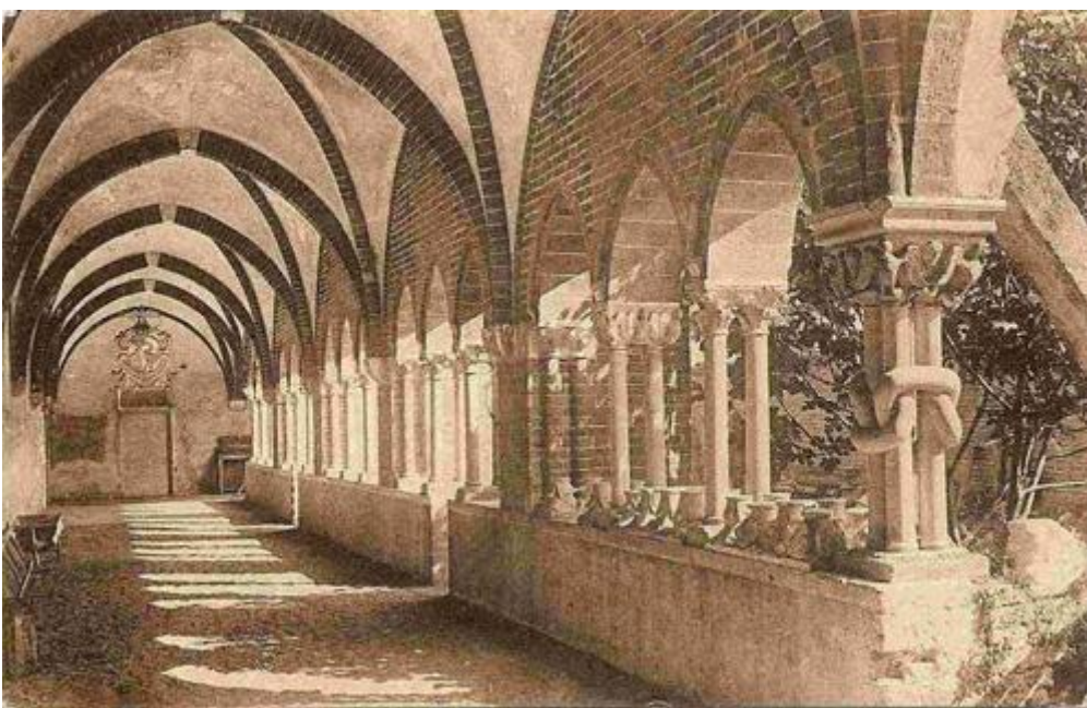
Il lato nord del chiostro dopo il restauro del 1895-97
