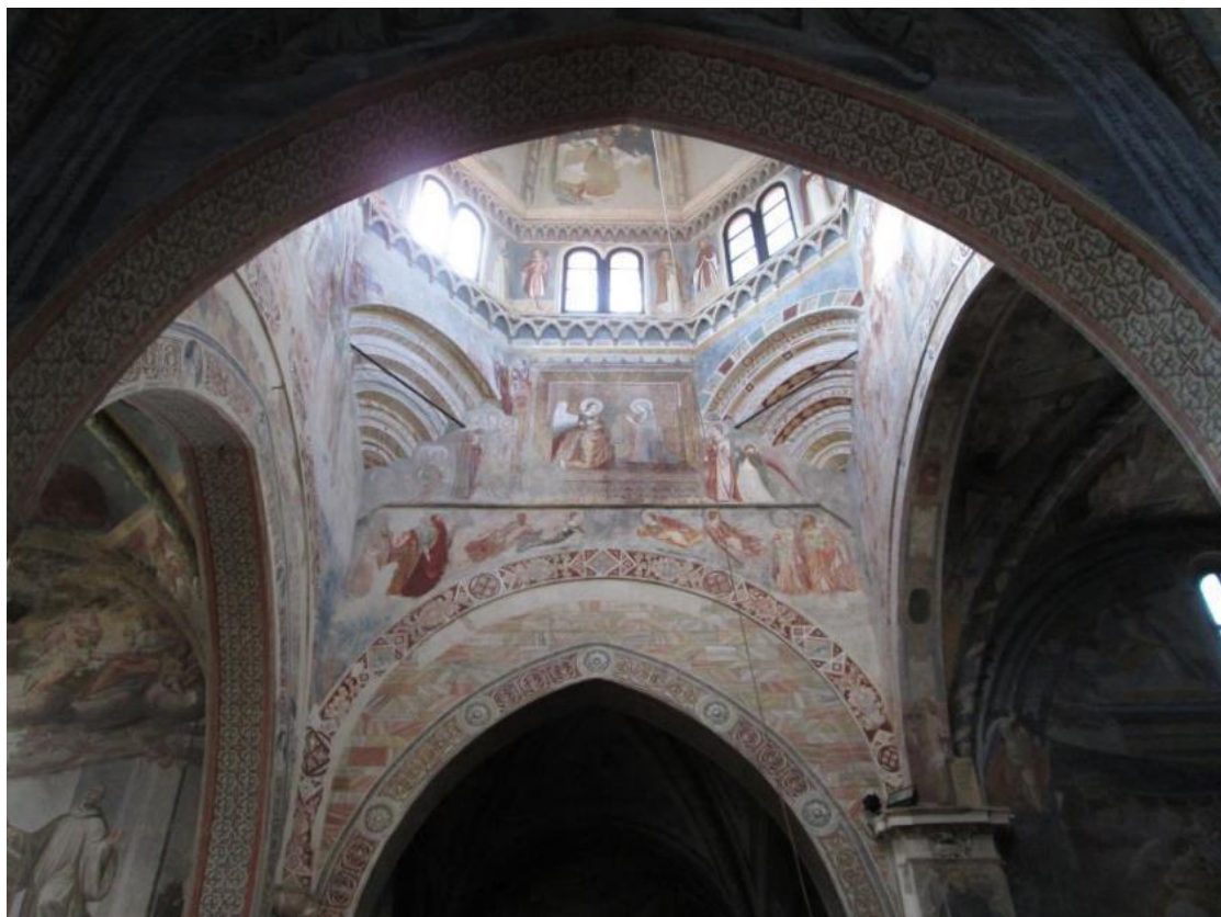
Il doppio sistema di archi di scarico con l'arco a sesto acuto e quello a tutto sesto.
