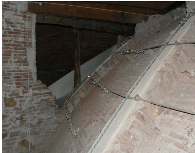
Realizzazioni dell'Arco Armato: in alto- Duomo di Colorno (PR); in basso- Santa Caterina a Lucca
