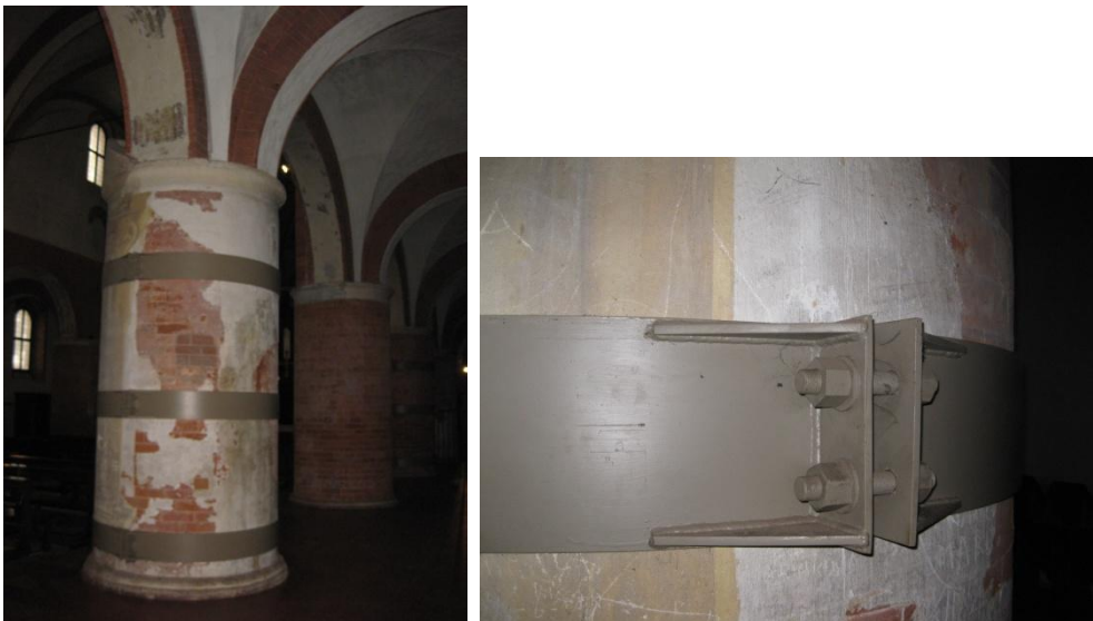
Le cerchiature dei pilastri della navata
