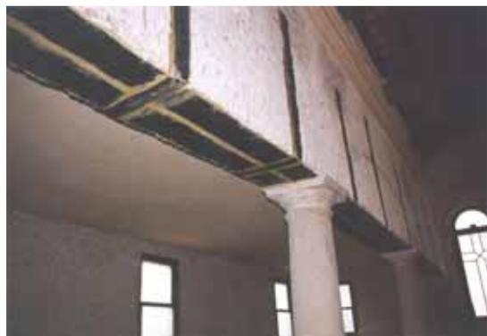
**Figure 7 a ,b, c, d. I danni riscontrabili sulle volte ed il restauro strutturale realizzato utilizzando materiali fibrorinforzati**
