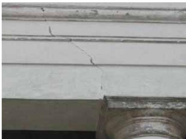
**Figura 3 a, b. Il rilievo del quadro fessurativo**
