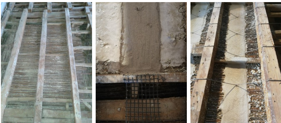
Figura 5. Da sinistra: strato di fatto all'estradosso di un riquadro; malta e rete di consolidamento; sistema di appensione in trefoli di acciaio
