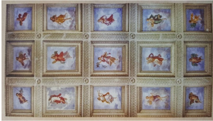
Figura 6. Vista dell'intradosso al termine del restauro.
