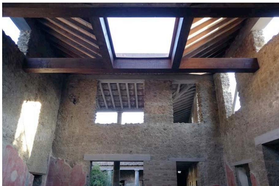
25. La nuova copertura della Casa degli Amanti Felici: (a) nuova struttura in acciaio, (b) posa dei travetti lignei, (c) piastrelle in cotto di nuova fattura, (d) sistema di scolo delle acque, occultato tra le foderie in legno che rivestono la struttura portante in acciaio, (e) strato di malta impermeabilizzante successivamente coperto da tegole, (f) vista interna a lavori ultimati (foto di arch. B. De Nigris).
