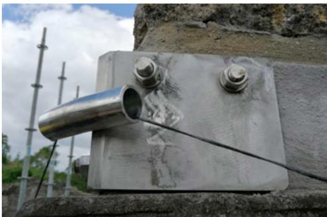
15. Dettagli delle piastre di ancoraggio al tetrastilo durante il cantiere (foto di arch. B. De Nigris).
