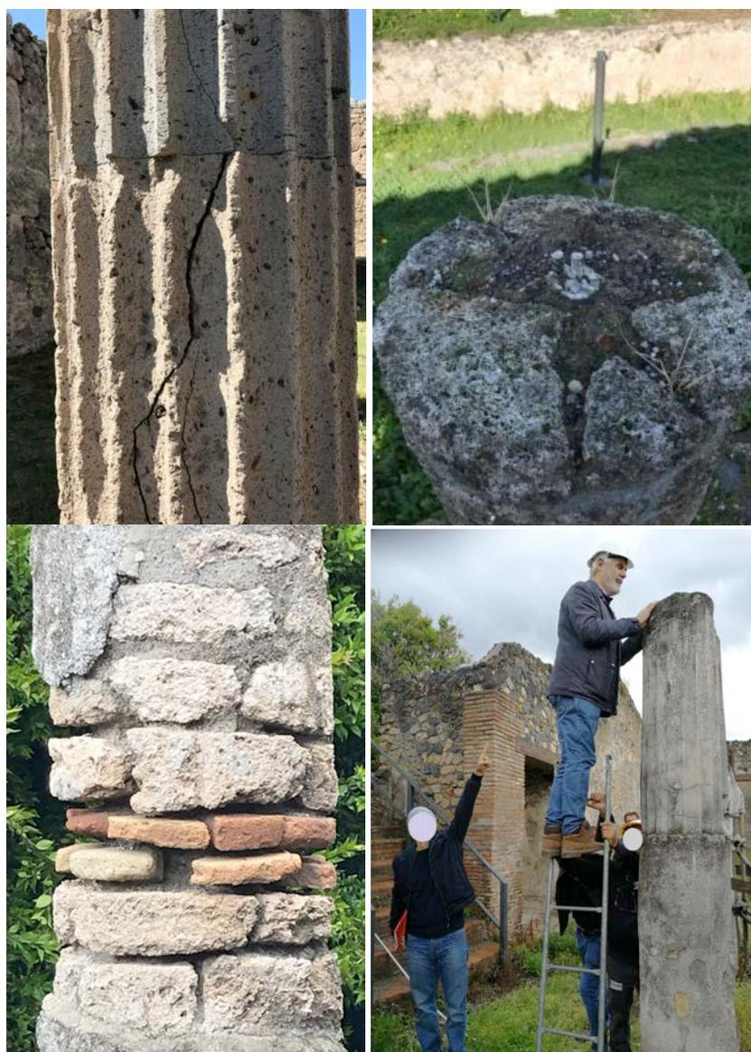
**16.** Stato di fatto delle colonne: (a) colonna lesionata a causa di presenza di ferri di armatura, (b) presenza di armature inghisate nell'area centrale della colonna, (c) mancanza di giunti di malta, (d) il Prof. Jurina intento a verificare la presenza di eventuali barre di armatura inserite nelle colonne (foto degli autori).
