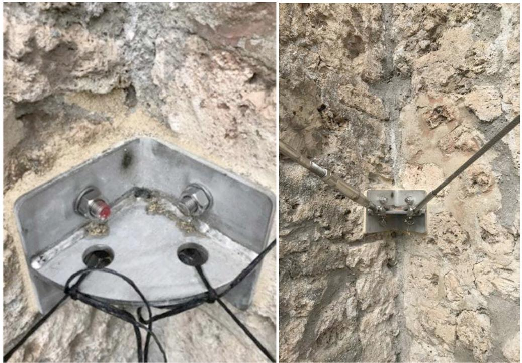
14. Dettagli delle piastre di ancoraggio alle pareti: (a) durante il cantiere e (b) a lavori ultimanti (foto degli autori).
